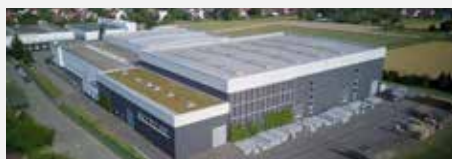
Hugo Brennenstuhl GmbH & Co. KG Werk 2 / Factory 2 / 2. üzem
