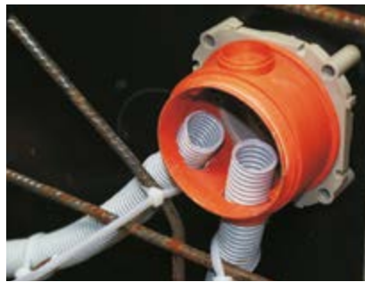
A KBT palástjába szerelt hajlékony csövek.
