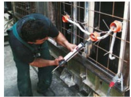
Az átvezetések tömítése (gitt).
