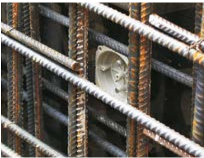
A zsaluzatra erősített KBV fedél.
