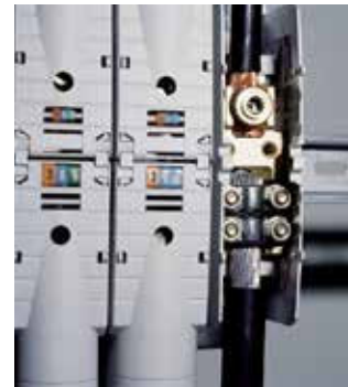
Közvetlen csatlakozás Al/Cu
